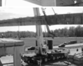
Zamjena elemenata nosive konstrukcije na nadvožnjaku u Ivanić Gradu
