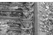
Vidljivi trag procurivanja u liniji prekida hidroizolacijskog sloja u liniji rubnjaka, te korozija armature gornjeg područja konzole kolničke ploče, u istoj liniji
