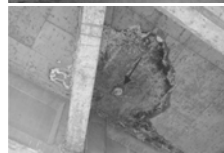
Prikaz razvoja oštećenja betona kolničke ploče oko mjesta čepljenja rupa za pridržanje oplata tijekom izvedbe
