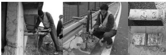
Popravci i zaštita AB konstrukcija
