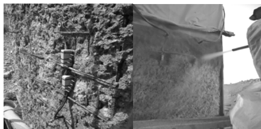
Ugradnja senzora za praćenje razvoja korozije na nivou armature, prije nanošenja novog zaštitnog sloja torkretiranjem. Ugrađen na stupu S29 na Krčkom mostu, mali luk
