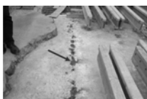
Vidljivi trag procurivanja u liniji prekida hidroizolacijskog sloja u liniji rubnjaka, te korozija armature gornjeg područja konzole kolničke ploče, u istoj liniji
