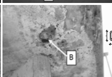
Most Črnci i Lonja: prodor vode sa solima kroz radnu rešku ispod konzole pješačke staze („A“), te na mjestu prodora cijevi za odvodnju ispod slivnika („B“)
