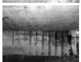
Pogled odozdo na istom mostu – vide se pukotine u podgledu i tragovi curenja vode po zidu upornjaka iz svih 12 štednih otvora.
